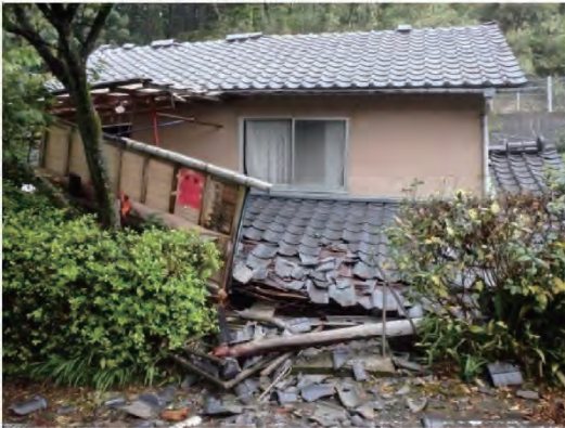
熊本地震の被災家屋（西原村）
