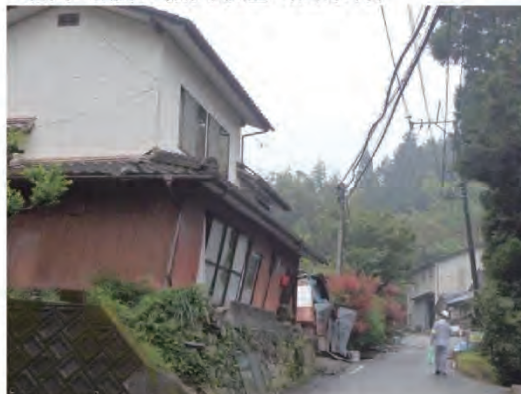
熊本地震の被災家屋（西原村）
