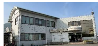
防災センター
