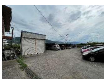
⑨ 西事務所（西側ガレージ）
