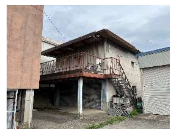
⑪ 西事務所（西側倉庫）
