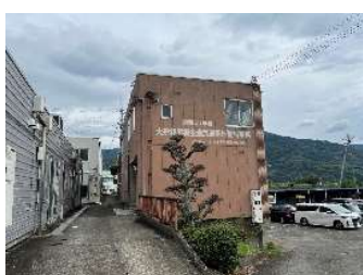
⑩ 西事務所（旧有線放送施設）
