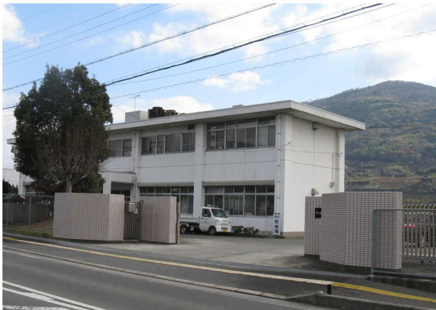
写真 1-2 かつらぎ町上下水道課庁舎の正面玄関
