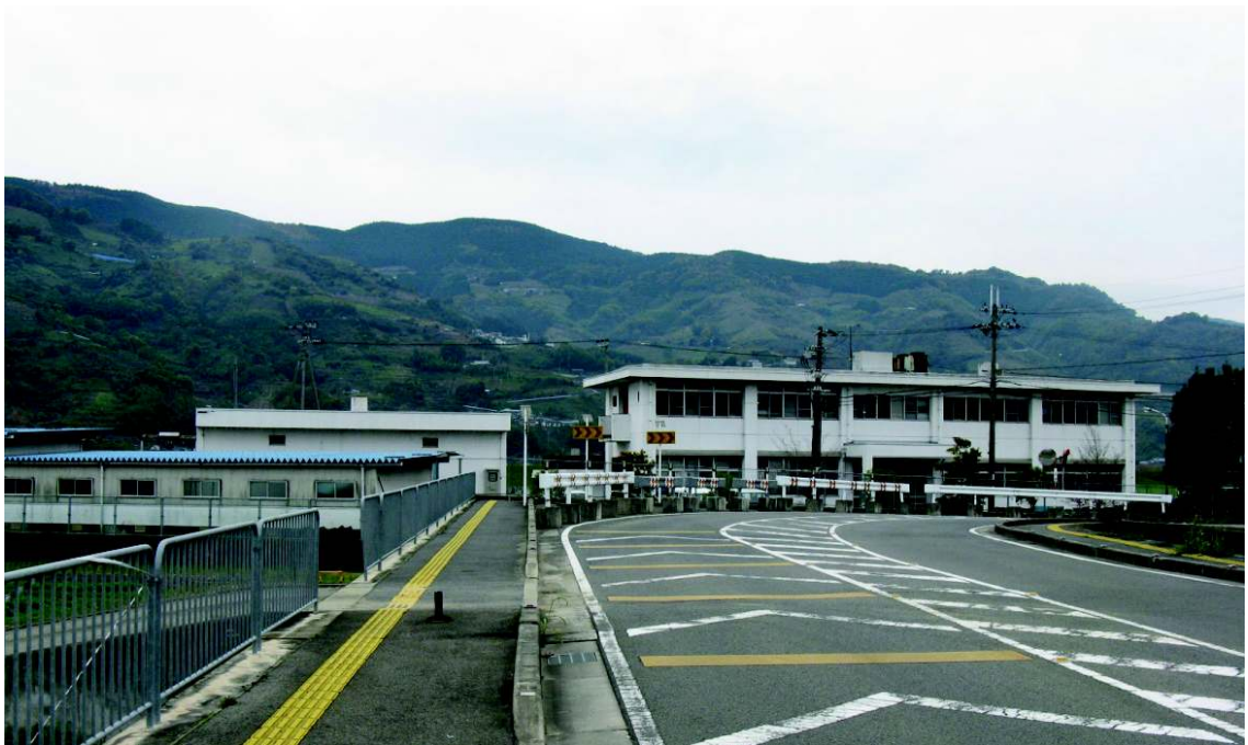
写真 2-2 かつらぎ町上下水道課庁舎及び佐野浄水場の全景
