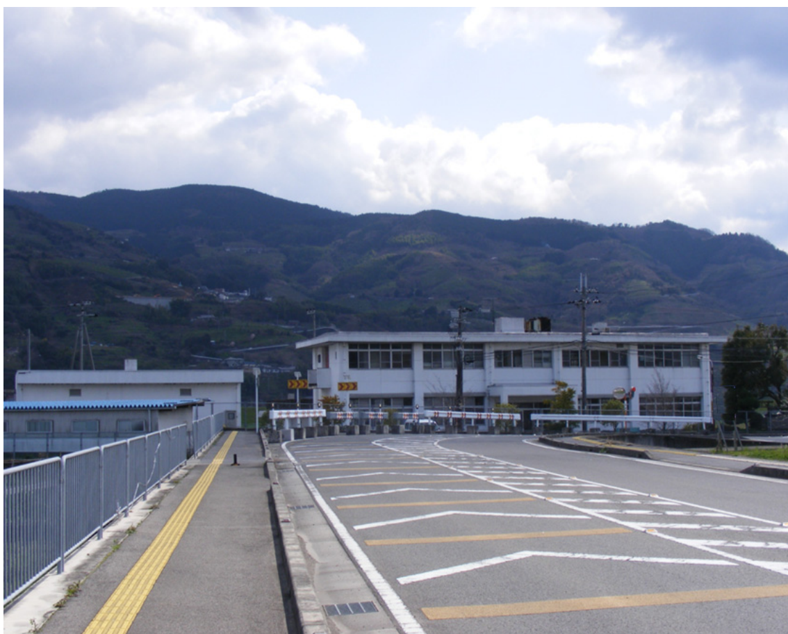
写真 4-1 かつらぎ町上下水道課庁舎及び佐野浄水場全景
