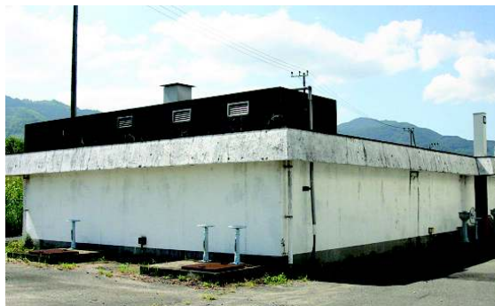
写真 4-9 着水井、浄水池
