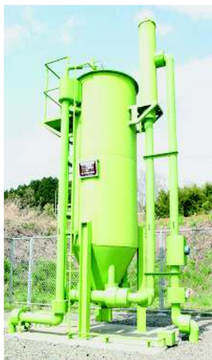
写真 4-44 移動床前処理装置
