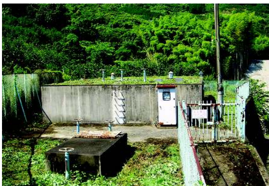
写真 4-76 渋田配水池(容量:228m 3 )
