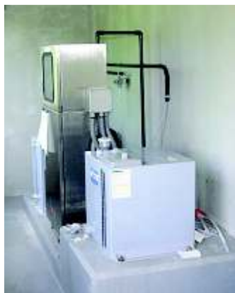
写真 4-46 薬品注入装置
