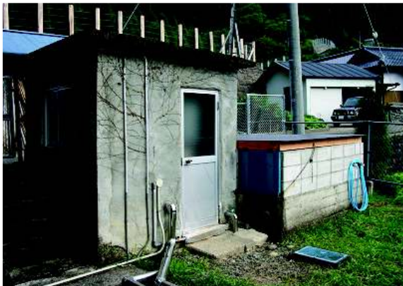
写真 4-71 浄水場(滅菌室、配水池)
