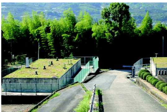
写真 4-74 妙寺配水池(容量:620m 3 )
