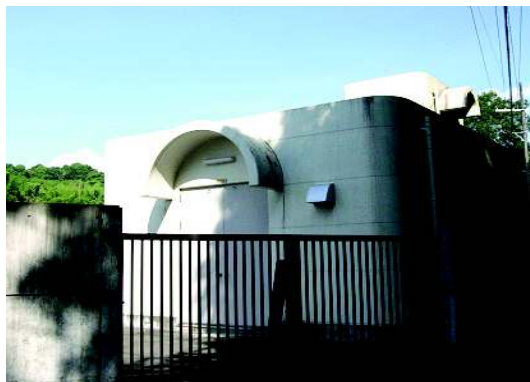
写真 4-79 城山中継ポンプ場
