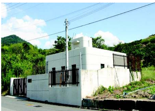
写真 4-78 柏木中継ポンプ場
