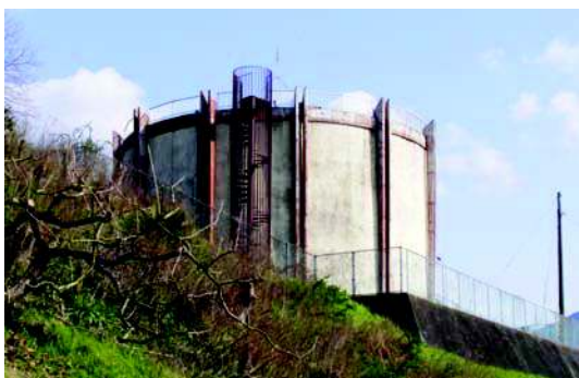
写真 4-72 大谷配水池(容量:2,000m 3 )
