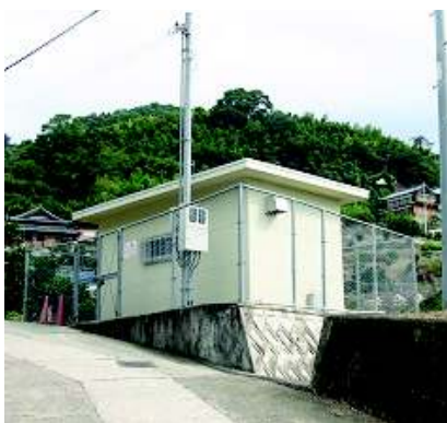
写真 4-80 上平沼田第2中継ポンプ場
