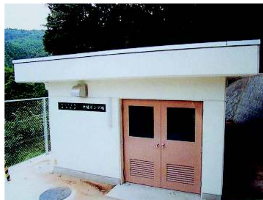
写真 4-81 御所中継ポンプ場
