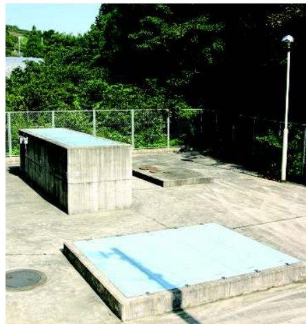
写真 4-37 着水井(沈砂池)
