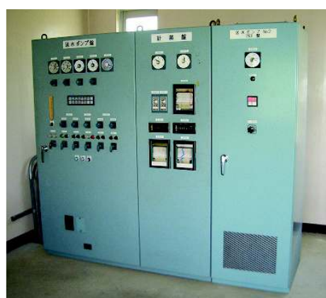
写真 4-33 テレメーター
