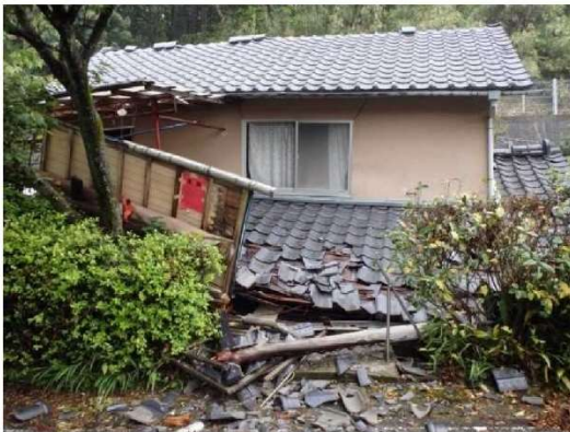
熊本地震の被災家屋（西原村）
