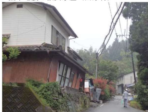
熊本地震の被災家屋（西原村）
