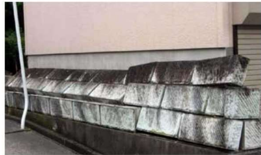
出典 (一財)消防科学総合センター
