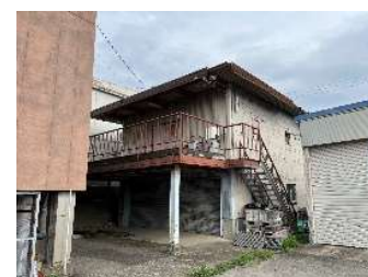
⑪ 西事務所（西側倉庫）
