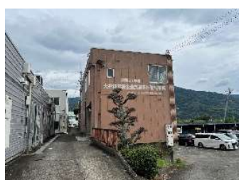
⑩ 西事務所（旧有線放送施設）
