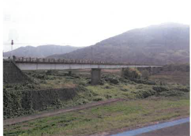
下流側から撮影
