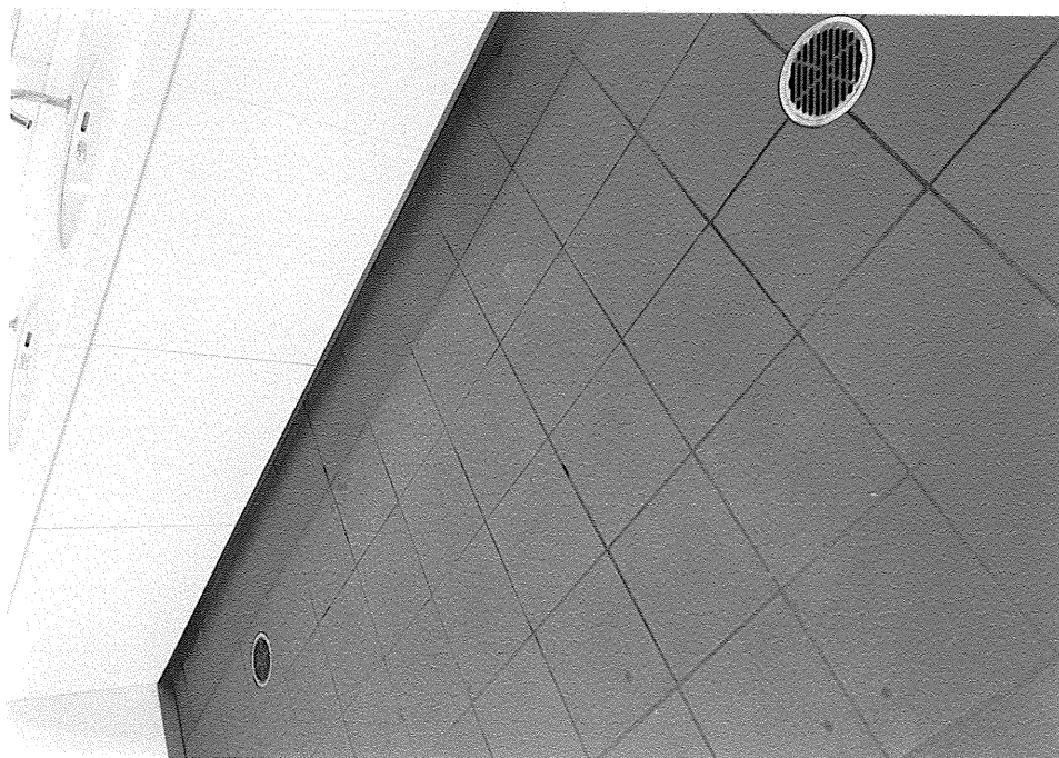
床排水トイレ内の床排水口
