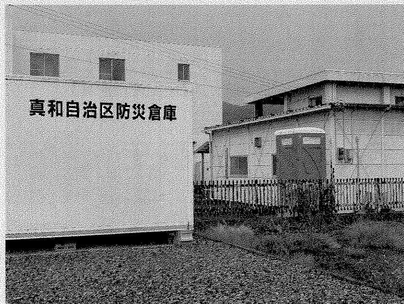
真和防災倉庫及び防災事務所
