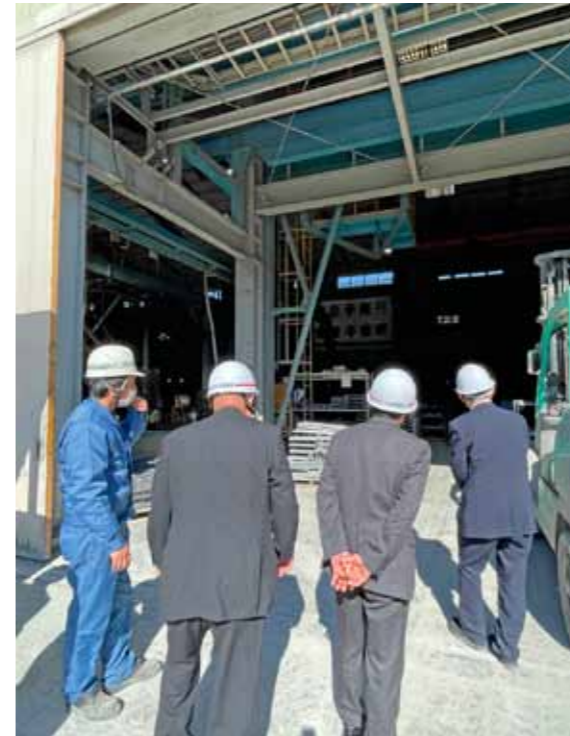
製造工程の説明を受ける(松阪興産株式会社)
