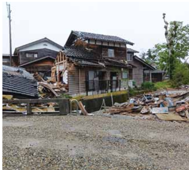
撤去されないままの家屋(2024年5月 珠州市)
