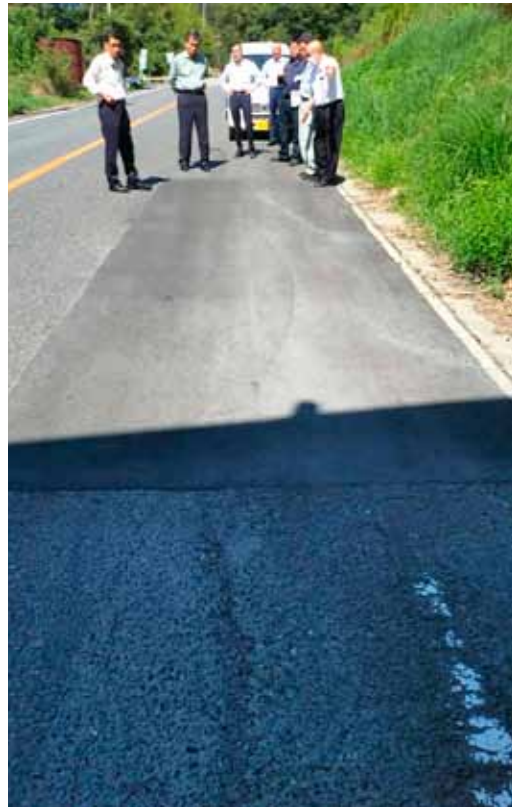
道路改修済みの現場を視察(広浦地内)
