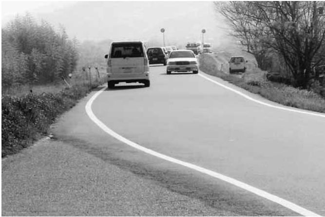
現況保全が望まれる河南県道
