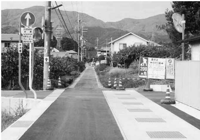
早期完成が望まれる妙寺46号線
