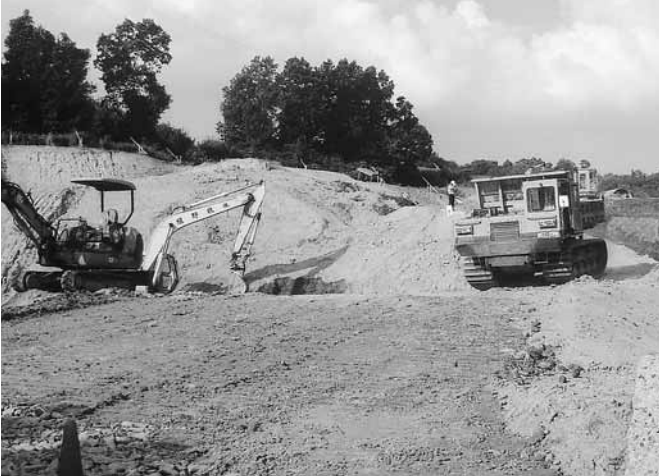
工事用道路（中飯降地内）
