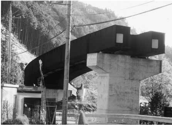
国道480号平バイパスの架橋工事
