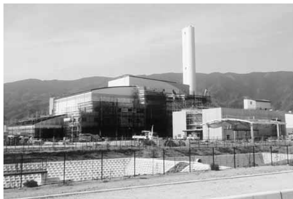
広域ごみ処理施設
