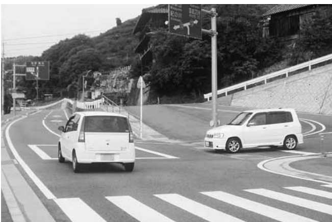
改善が必要な新県道交差点 (三谷地内)
