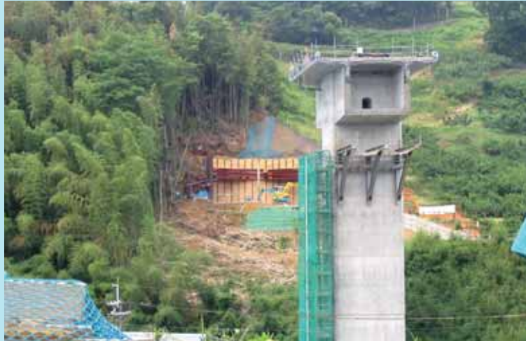
嵯峨谷川橋工事現場
