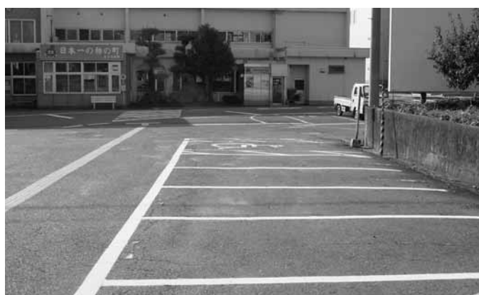
車止めがない役場庁舎前駐車場
