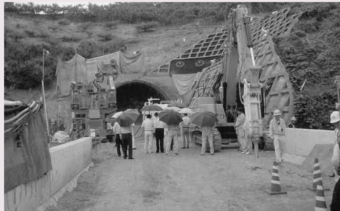
左岸農道の平沼田トンネル工事現場
