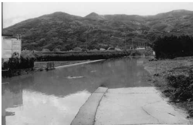
増水した藤谷川
