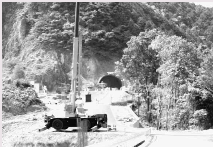
建設中の父鬼バイパス(第2工区)
