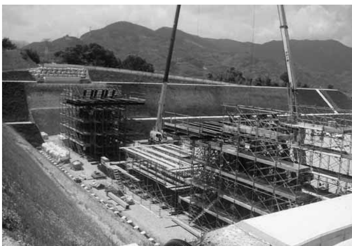
橋梁工事が進む中飯降地内
