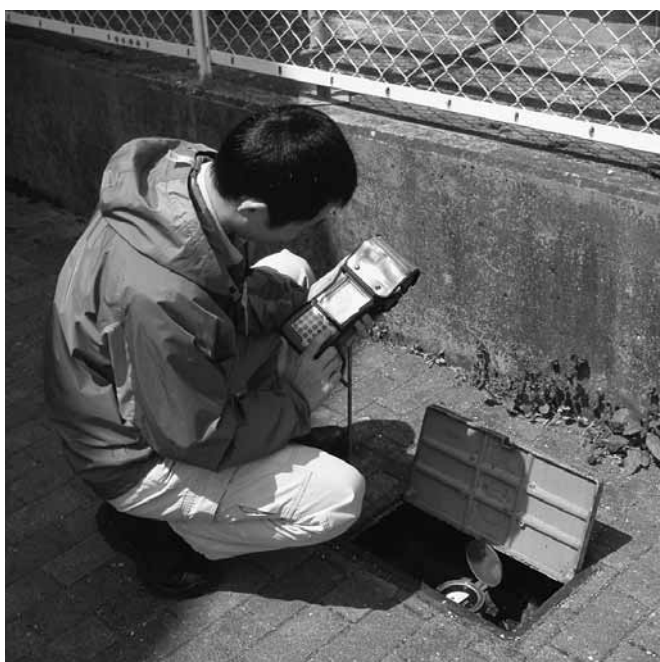
水道メーター検針中
