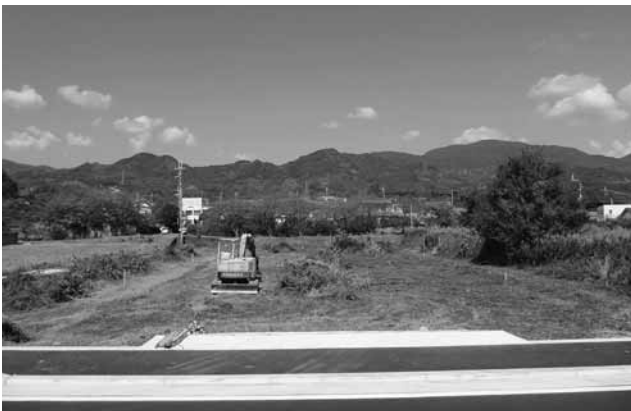
造成中の町民農園（地域福祉センター東）
