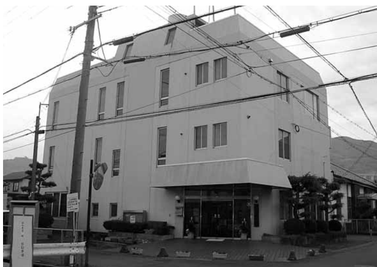
改修予定の妙寺公民館
