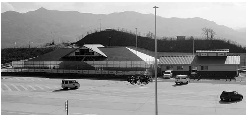
建設中のかつらぎ西PA（南側）
