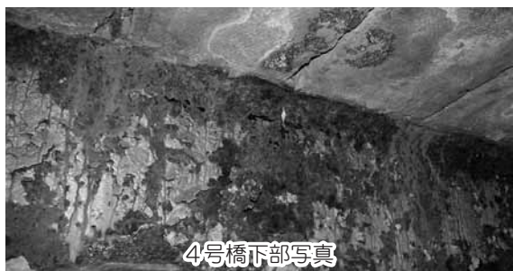
修繕予定の見好4号橋（東茨田地内）
