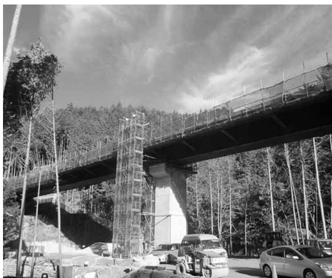
父鬼バイパス橋梁工事
