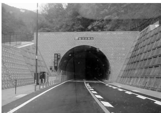
府県間トンネル（和歌山県側）
