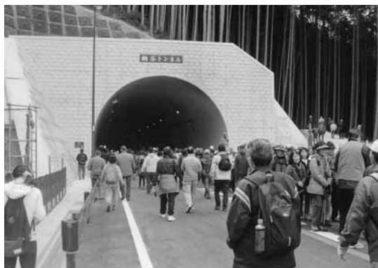
府県間トンネル（大阪府側）
