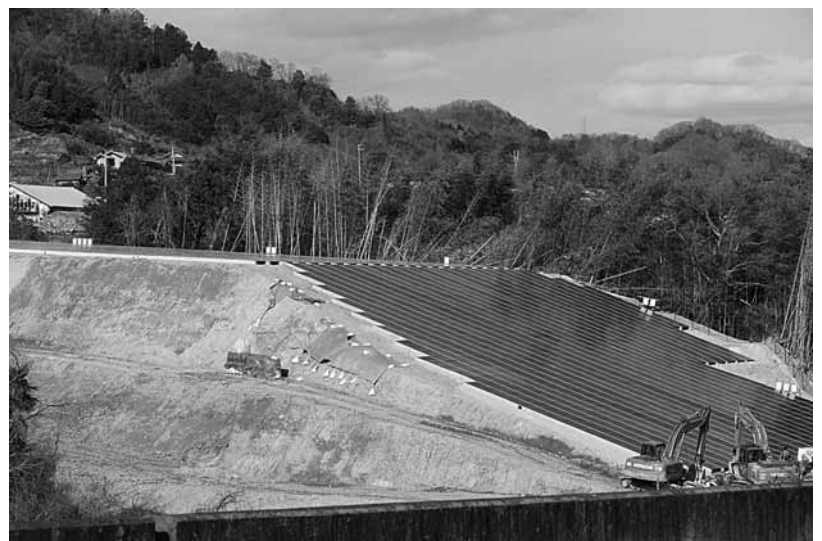
太陽光パネル（柏木地区）
