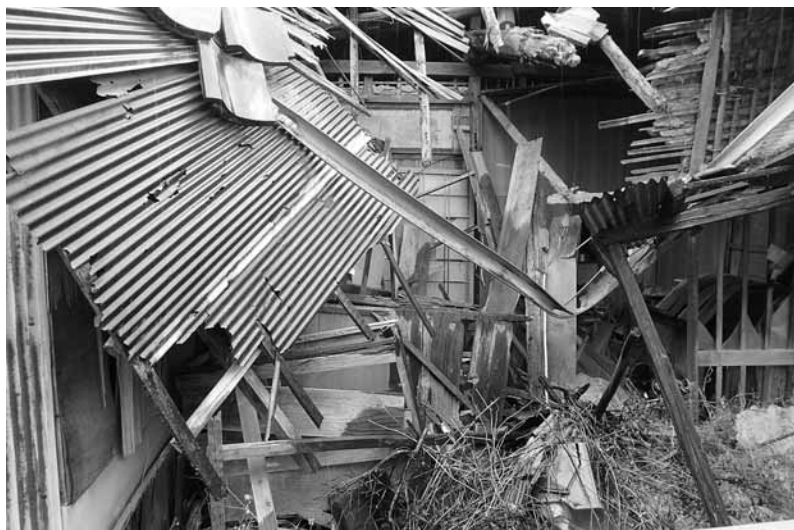
調査が進む空き家
