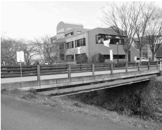
安全点検を求められる仮設橋
