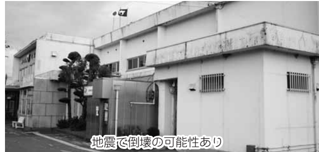
職員にも危険が及ぶ 早い耐震改修が待たれる現庁舎
