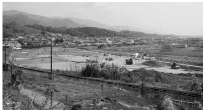
背の山から見た建設中のパークゴルフ場
