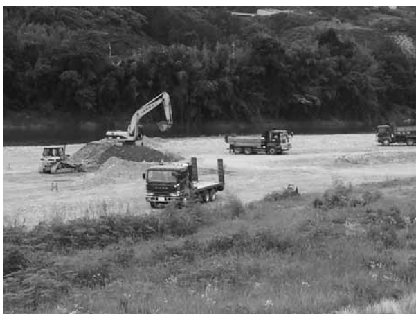
紀の川掘削作業
