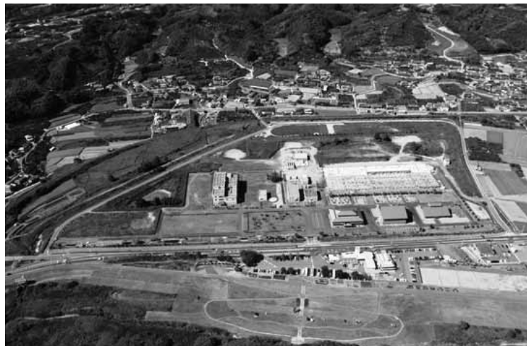
伊都浄化センター
