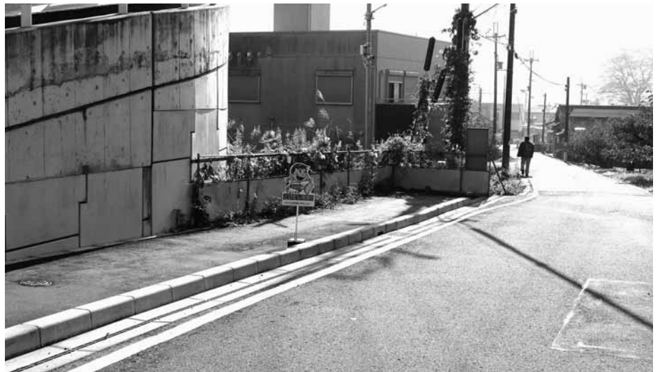
途中で立ち切れ放置の危険な歩道
