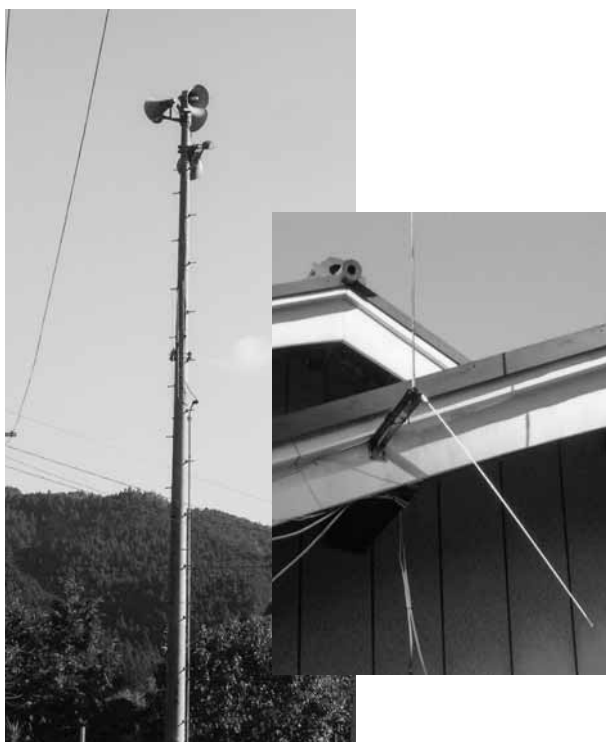
防災行政無線屋外スピーカー・室内受信アンテナ (有田川町)
