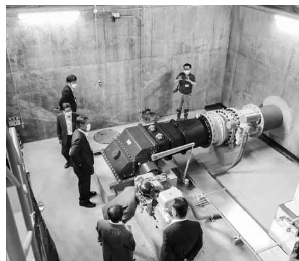
花園の小水力発電、80世帯の電力をカバーできる
